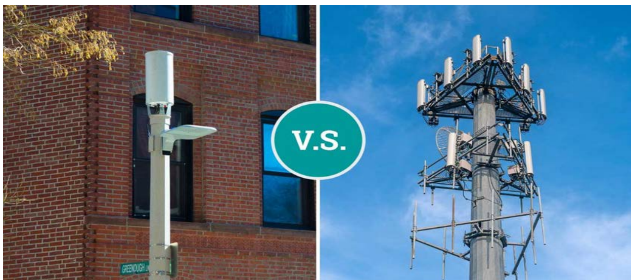
Сурет 2.2 - Small cells шешімі (сол жақтағы), алдыңғы буын желілеріндегі тұрақты Macro BTS базалық станциямен салыстырғанда
